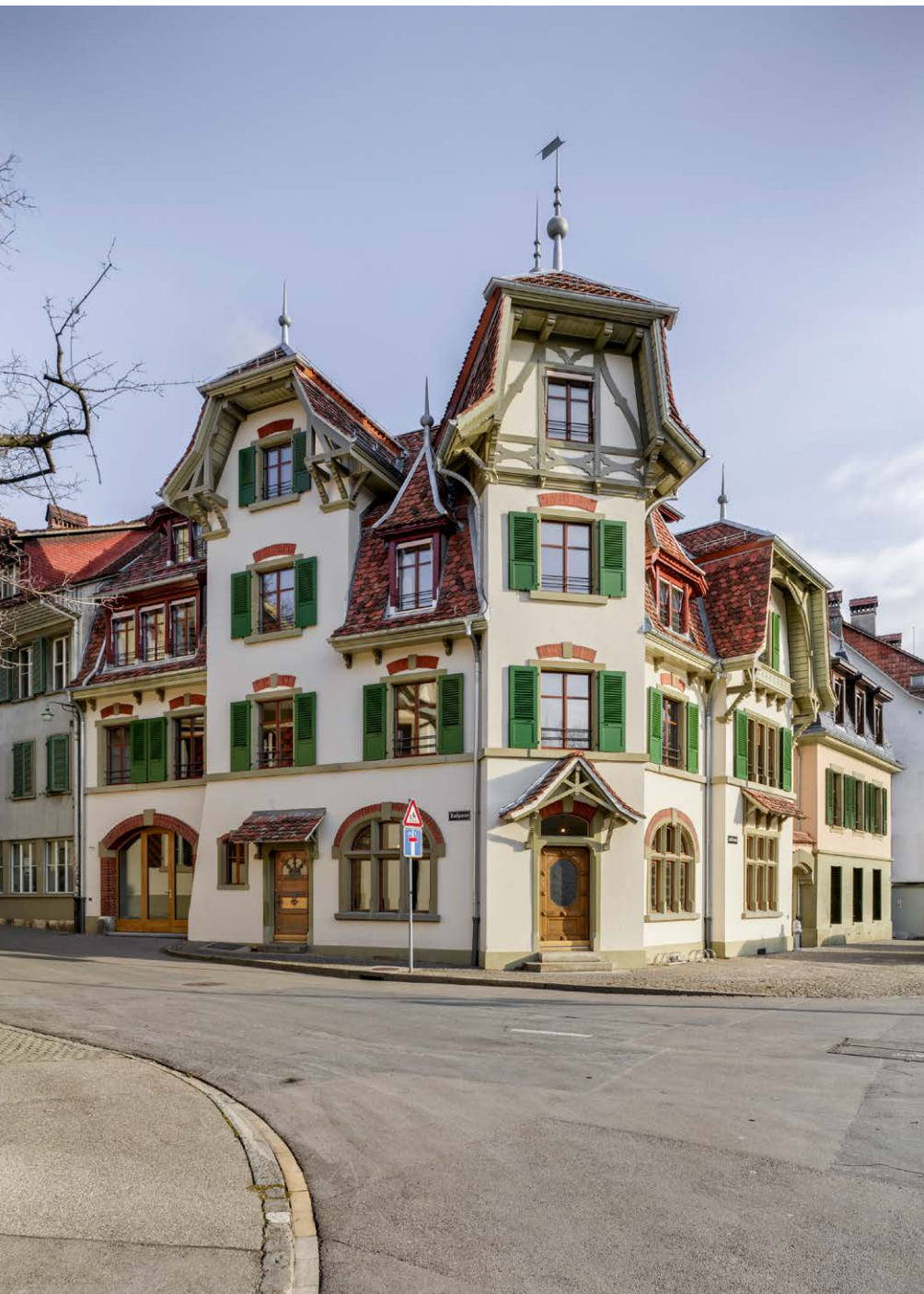
Die Fassade an der Ecke Schiffлаube / Badgasse mit rekonstruierten Architekturelementen und wiedergewonnener Farbigkeit. Bild: Alexander Gempeler, 2019.
