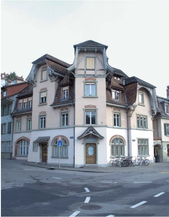
Zustand Fassade an der Ecke Schiff-laube / Badgasse vor der Sanierung. Bild: Denkmalpflege Stadt Bern, 2015.
