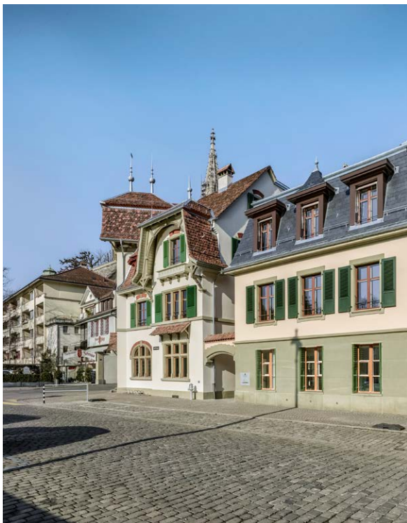
In der bauzeitlichen Farbgebung rekonstruierte Fassaden Schifflaube 50 und 52. Bild: Alexander Gempeler, 2019.
